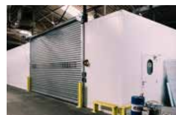
Ligne de fabrication des panneaux sandwich
