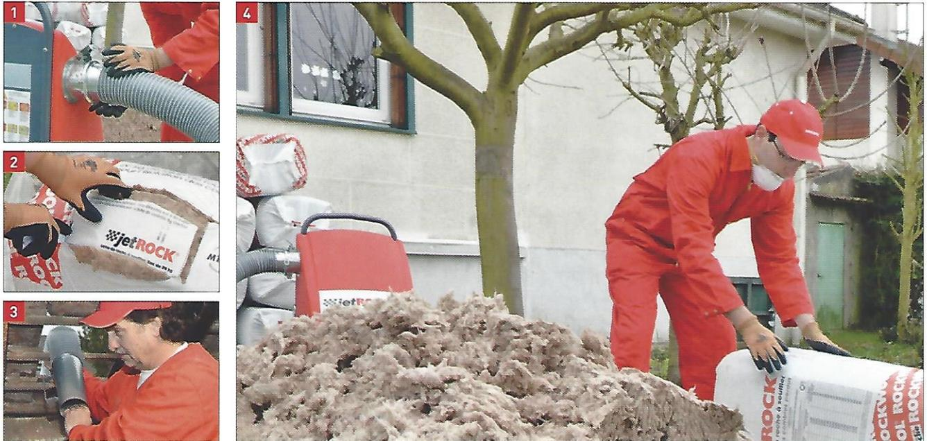
① La machine à souffler est prête à l'emploi. ② Découper les étiquettes avec le numéro de contrôle. Elles serviront à la traçabilité du chantier. ③ Passage du tuyau du sol aux combles pour souffler Jetrock. ④ Verser la laine de roche et l'aérer.
