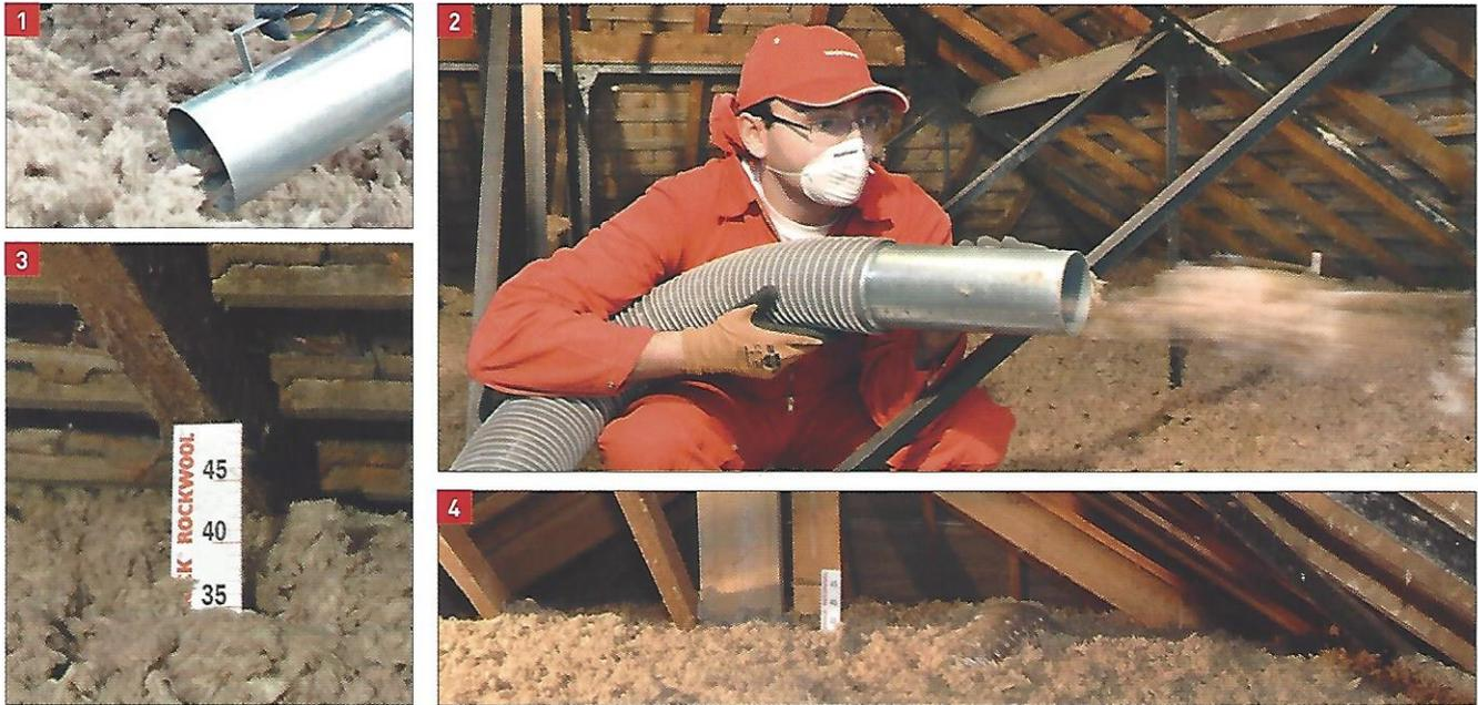
① Devant la maison, un des poseurs aspire JETROCK avec l'extrémité du tuyau. ② Le deuxième isocombliste souffle la laine de roche dans le comble de façon homogène. Les ponts thermiques sont ainsi neutralisés. ③ Les piges préalablement réparties permettent de repérer facilement lorsque le niveau de performance visé est atteint. ④ Une fois terminé, le comble perdu devient sans équivoque un manteau de laine de roche, efficace hiver comme été.
